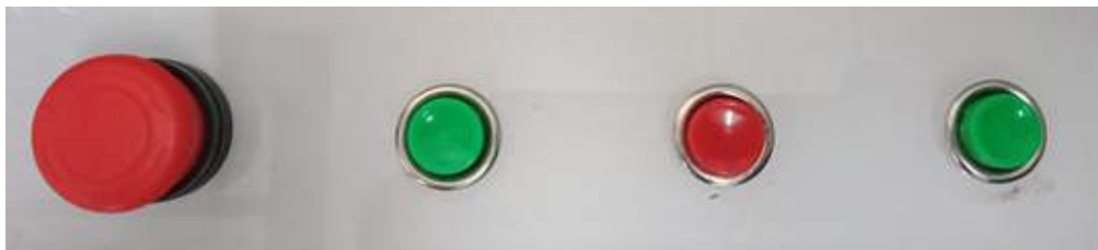
Hình 3.4. Hệ thống nút bấm.
