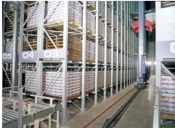
Hình 1.3. Các cơ cấu lấy hàng của hệ thống ASRS.
